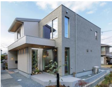
タイルと吹き付けを貼り分けることで、素材感を出したスクエア型の外観
