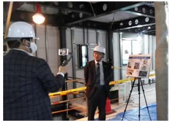
新築現場における技術説明の様子
